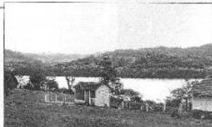
Uma das propriedades que será alagada, caso a barragem seja construída
