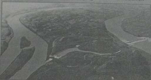
Imagem de como ficará a obra. No detalhe à esquerda, Ilha Redonda
