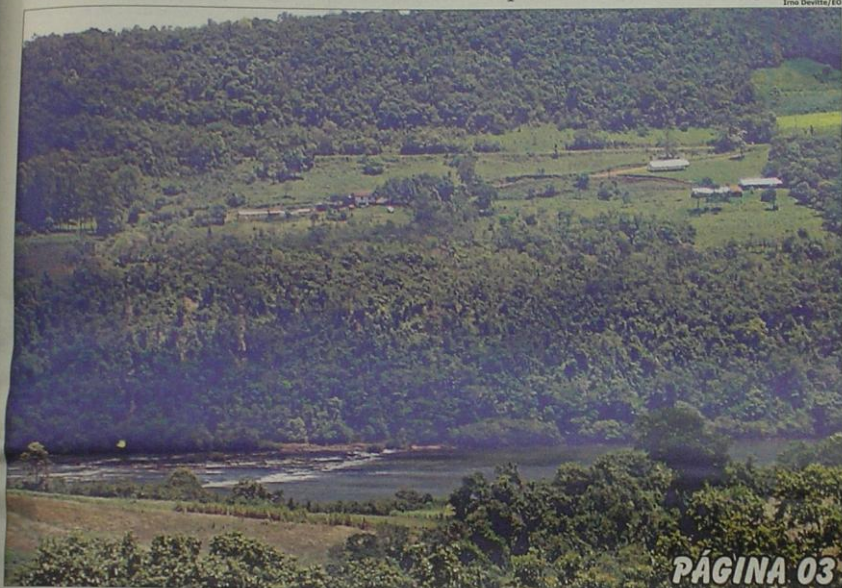
Vista parcial do Saltinho do rio Uruguai onde será construída a barragem. No lado gaúcho de Alpestre, observa-se galpões que abrigam agricultores e lideranças do MAB
