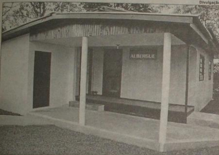
Vista parcial da casa do migrante
